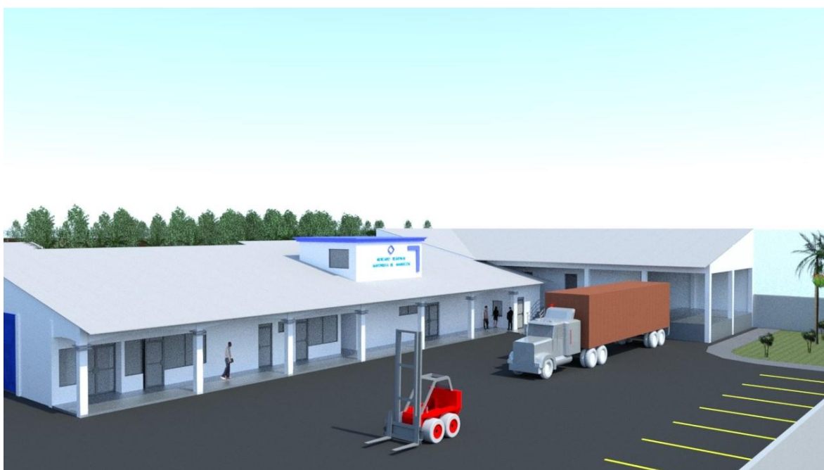
Figura 75: Vista frontal de planta procesadora Terminal Pesquera Limón
