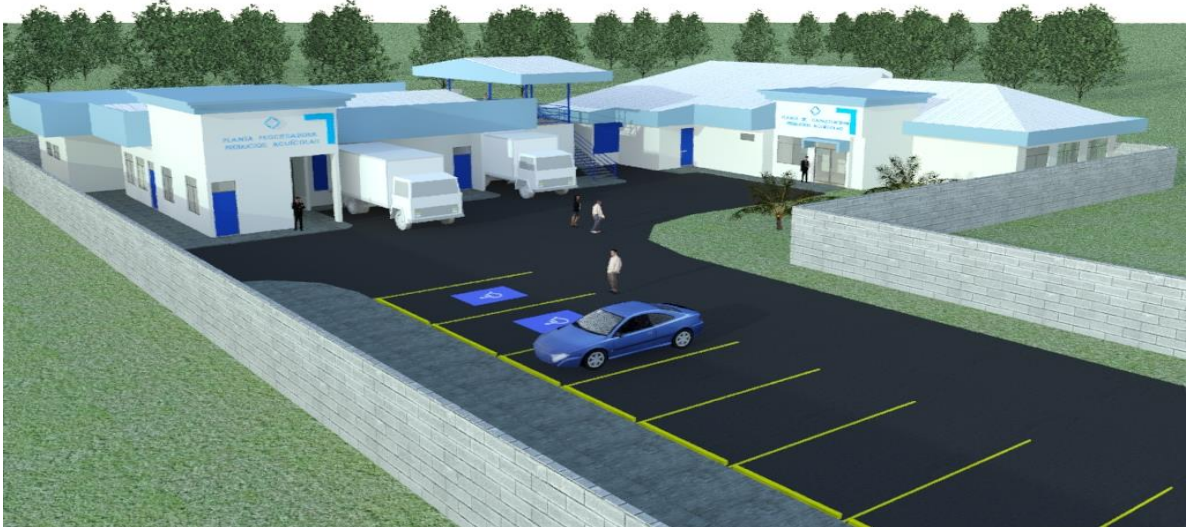
Figura 86: Vista panorámica infraestructura Los Diamantes
