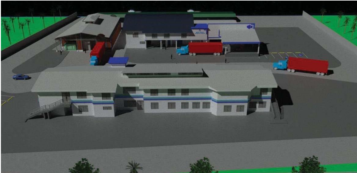
Figura 70: Vista aérea de la infraestructura Terminal Pesquera Puntarenas
