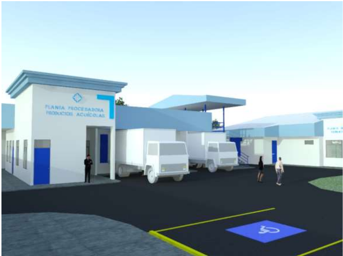
Figura 29. Vista frontal de Planta de Proceso
