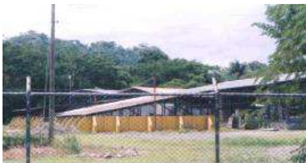
Figura 33: Planta de tratamiento de la Empresa Formuquisa, en la cual se observa que se levantaron las paredes de la misma, además fue techada.
