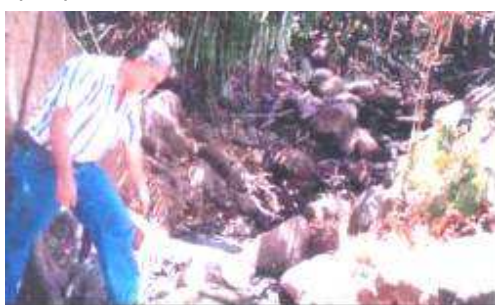
Figura 36: El Sr. Diego Sandí, muestra el canal por el cual llegaban las aguas contaminadas de la Porqueriza Los Ángeles a su finca.
