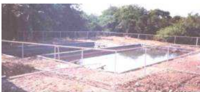
Figura 38: Plata de tratamiento de aguas residuales de la Liga Industrial de la Caña (LAICA) ubicada en Punta Morales.
