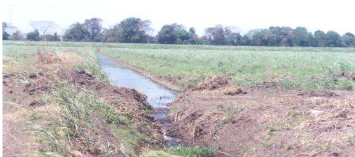
Figura 5: Aguas residuales provenientes del Ingenio El Palmar, las cuales caen posteriormente al Estero Los Negros, el día 21-02-06.
